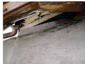
屋根裏につながる隙間
